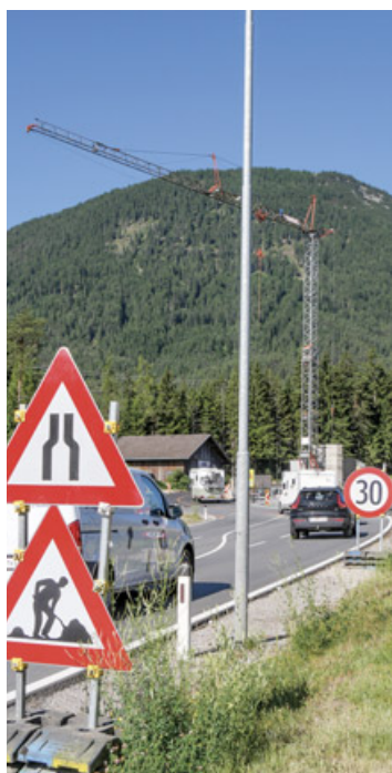
Die Baustelle für die Unterführung am westlichen Ortsende soll im Oktober beendet sein
