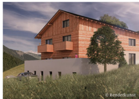
Moderner Holzbau in der kleinsten Gemeinde Tirols.
