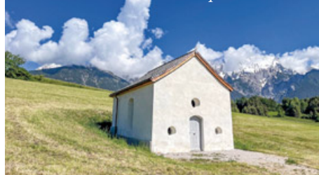
Frisch restauriert: Die Feldkapelle in See
