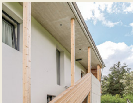
Auf der Nordseite wurde ein neuer außenliegender Treppenaufgang zum Obergeschoss geschaffen
