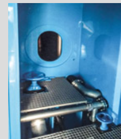
Die Wasserkammer (o.) ist im Fertigteil-Hochbehälter (l.) samt Schieberkammer (vorne quer) integriert
