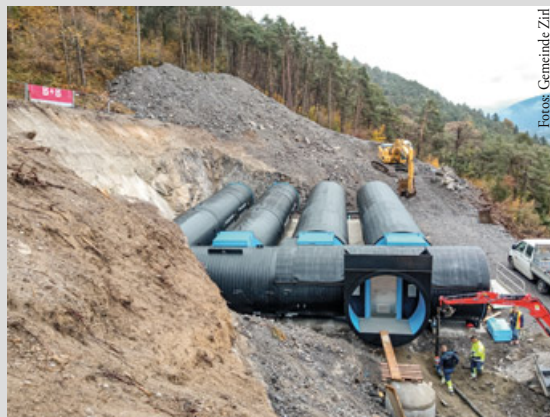
Die Wasserkammer (o.) ist im Fertigteil-Hochbehälter (l.) samt Schieberkammer (vorne quer) integriert
