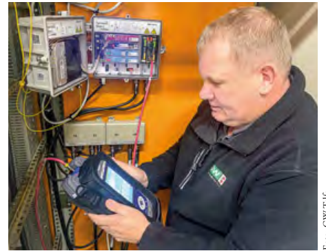
Klaus Kluckner, GW Telfs-Teamleiter für Internet und Kabel-TV, bei einer Messung am CMTS-System
