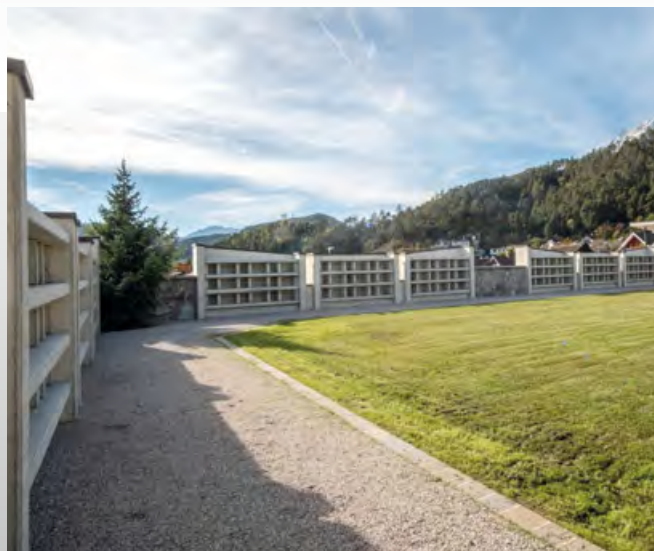
Die 81 Urnengrabbnischen an der westlichen Begrenzungsmauer am Georgenfriedhof wurden in die dafür vorgesehenen Mauerteile eingebaut
