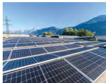
Zukunftsweisend: Auf den Dächern des Firmengebäudes in Inzing wurden neue Photovoltaik-Anlagen installiert.
