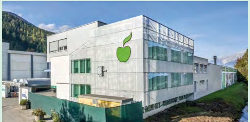
An seinem Firmensitz betreibt Freudenthaler unter anderem eine CPO-Behandlungsanlage, eine moderne Gewerbemüllsortieranlage sowie eine mehrstufige Verdampferanlage.
