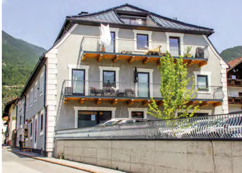
Der ehemalige Gasthof Hirschen präsentiert sich nach der Sanierung »aufgefrischt«
