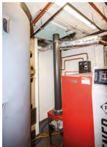
für wohlige Wärme und warmes Wasser sorgt eine Hackschnitzelanlage
