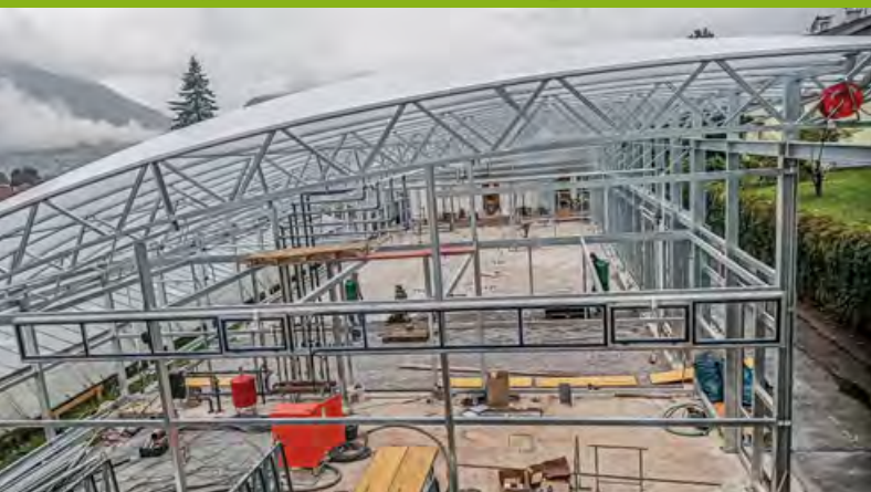
Luftige Höhen im neuen Glashaus der Gärtnerei Bernhart – hier noch in Bau
