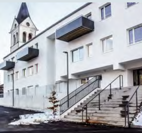
Das Kloster wurde zum modernen Mehrzweckgebäude
