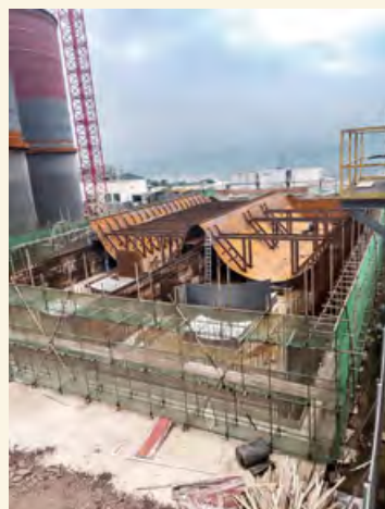
Bauarbeiten an der TTV Thöni Trockenvergärungsanlage in Luoqui - Chongqing
