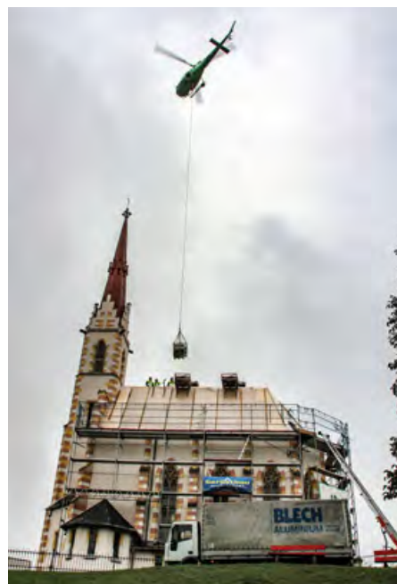
Die Schieferplatten wurden mit Hubschrauber auf das Dach transportiert, die Kupferverblechung und die Dachrinnen sind optisch ansprechende Blickfänge
