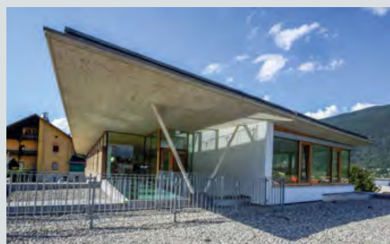
Unter dem markanten Pultdach der Volksschule Hatting entstand der neue Klassenraum in Nord-Ost-Ausrichtung
