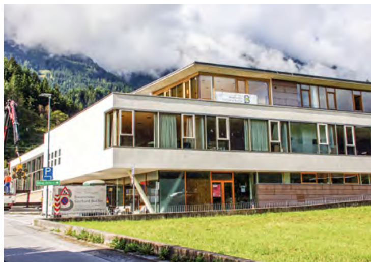
»Oben draufgesetzt«: Durch die Einhausung einer überdachten Terrasse wird in der Volksschule Hatting ein neuer Klassenraum geschaffen
