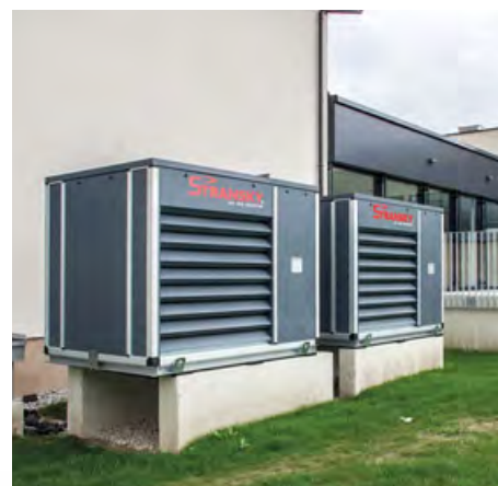
Die »äußeren« Merkmale der neuen Wärmepumpe, die Lüftungszentrale befindet sich im Dachgeschoss
