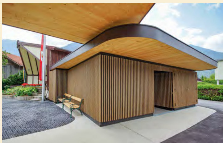
Die Gebäude wurden mit optisch ansprechender geradliniger Holzfassade versehen
