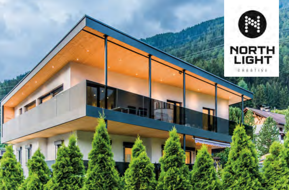
Die Aufstockung in Holzriegelbauweise wurde von Schafferer-Bau zur vollsten Zufriedenheit des Bauherrn durchgeführt
