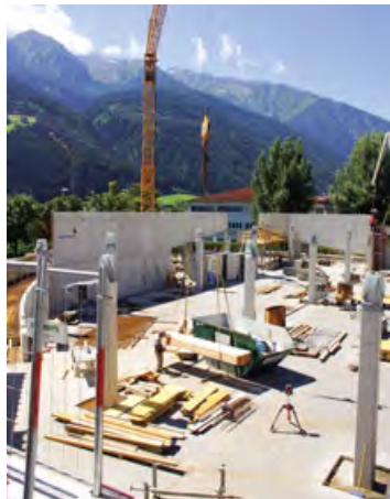
Die zweite Parkebene entsteht, die östliche Zufahrtsrampe wurde fertiggestellt
