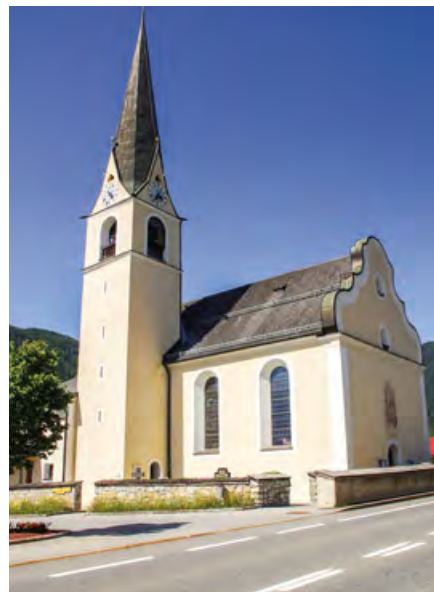
Nicht sichtbar von außen, aber notwendig: Der Dachstuhl bzw. das Holzgewölbe der Pfarrkirche musste verstärkt werden
