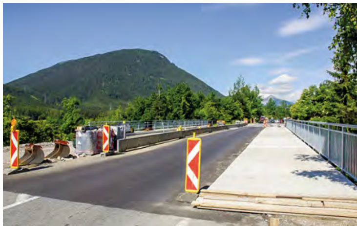
Im Zuge des Straßenumbaus wurde auch die Brücke im Obsteiger Ortszentrum saniert sowie die Straßenbeleuchtung erneuert, mit Ferienbeginn sollten die Arbeiten hier abgeschlossen sein
