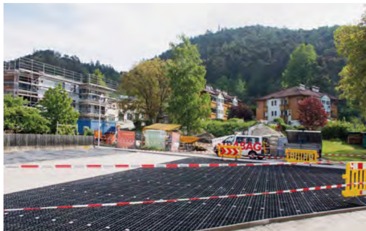
Straßensanierung und Wohnbau in der Wasserstatt (Garte 2) sollen heuer noch abgeschlossen sein, dann können sich hier die neuen GemeindebürgerInnen niederlassen und auch »glasfasernetz-schnell« im Internet surfen
