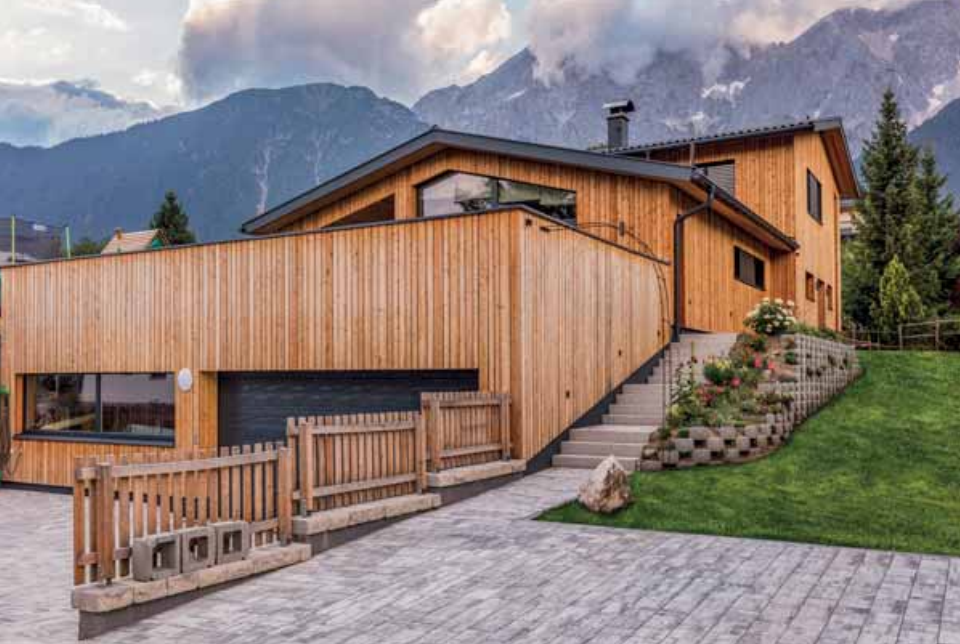
Die grauen Pflastersteine harmonisieren bestens mit der Lärchenfassade des Gebäudes
