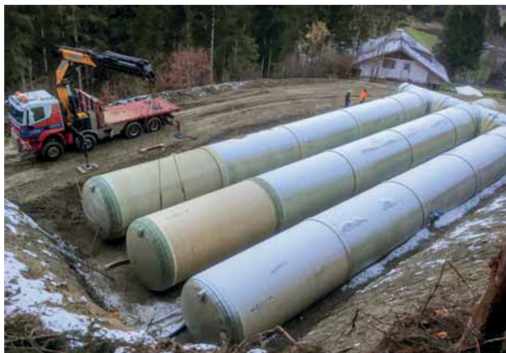
In den drei liegenden Glasfaserröhren des neuen Hochbehälters (jetzt unter der Erde) haben bis zu 500 Kubikmeter Trinkwasser Platz
