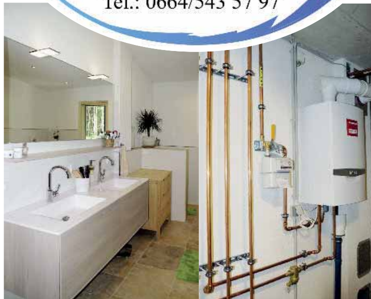
Damit es im Bad wohlig warm wird, kommt die Gastherme (r.) zum Einsatz
