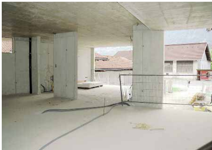
Große Fensterflächen sorgen in den neuen Kindergartenräumen für Licht und Luftigkeit, der Übergang zum alten Gebäude erfolgt über eine Rampe
