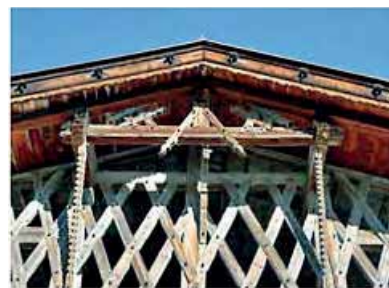
Durchbrochenes Bundwerk mit vorgesetztem Ziergiebel und Bügen an einem Mittelfurhaus in der Gemeinde Obsteig, Bezirk Imst.
