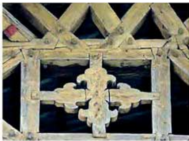
Detail eines Bundwerkgiebels in der Gemeinde Pfaffenhofen, Bezirk Innsbruck-Land: Ankerkreuz zwischen Schwelle und Riegel.
