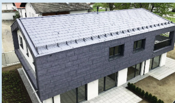
Aus einem Guss: Dach und Fassade aus Spenglerhand für eine moderne Optik mit Mehrwert
