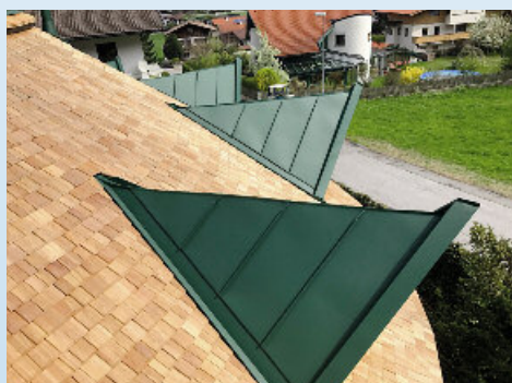
Reizvolle Spenglerarbeit in Kombination mit einem Schindeldach aus Holz
