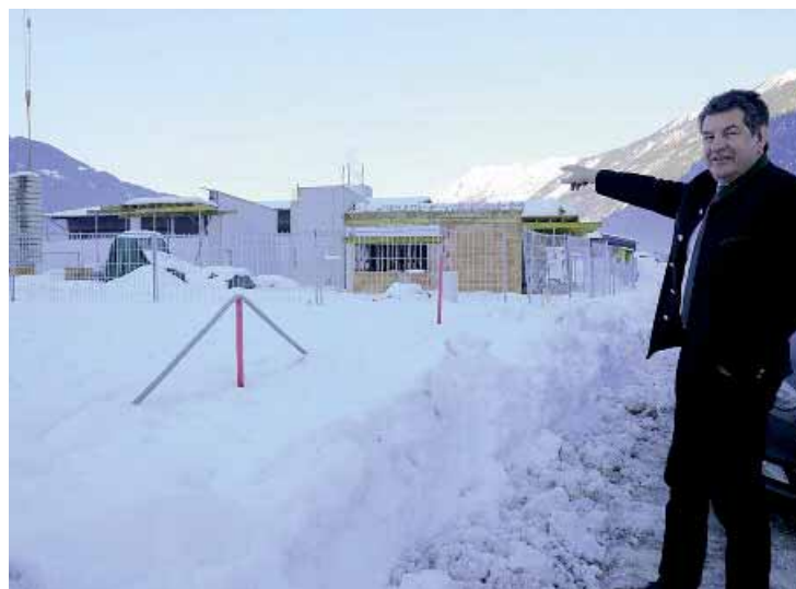
Der neue Bauhof der Gemeinde nimmt Formen an (unterm Schnee), Bürgermeister Helmut Dablander zeigt die Baufortschritte
