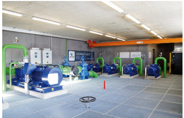
Die Pumpstation liegt unterhalb des Speicherteiches und wartet mit vollautomatischer Technik und leistungsstarken Pumpen auf. Willi Mareiler zeigt am Foto r.u. die baulichen Veränderungen im Gelände
