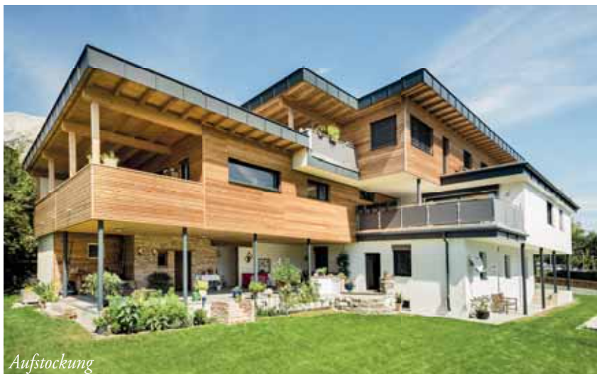
Blockriegel-Bauweise
