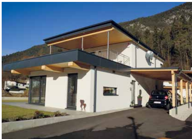
Praktisch: das Carport ist von beiden Seiten befahrbar
